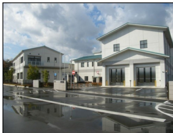
汚泥再生処理センター
