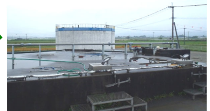
免田中継槽(旧免田し尿処理場貯留設備)
