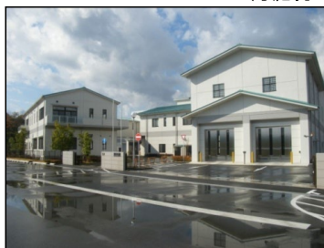
汚泥再生処理センター
