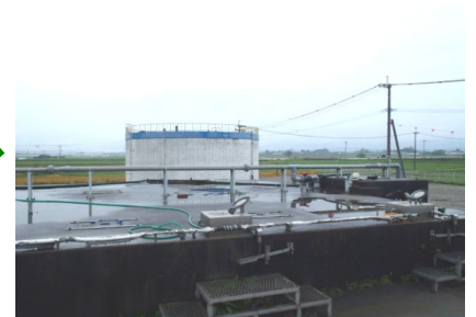
免田中継槽(旧免田し尿処理場貯留設備)
