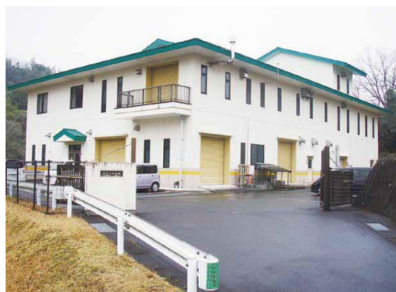
しんしゅつすいしよりとう 浸出水処理棟
